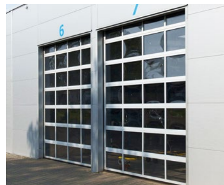
BRAMA SEGMENTOWA K2 IP z sekcjami przeszklonymi
